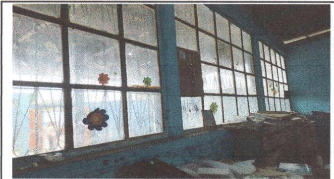
Foto 6: Sustitucion de ventana de madera por metal más vidrio parte inter
