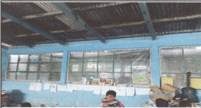
Foto 5: Sustitucion de ventana de madera por metal más vidrio parte frontal
