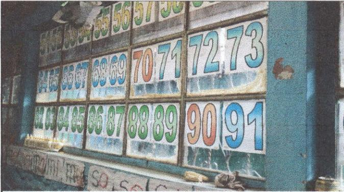
Foto 4: sustitución de ventana de madera por metal más vidrio parte interior
